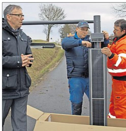
Für das Einbohren des Schraubfundaments, die Montage der Leuchte und deren Aufbau wurde gerade mal eine halbe Stunde benötigt, wie hier Photinus-Prokurist Richard Hutter (links) mit den Mitarbeitern demonstriert.
